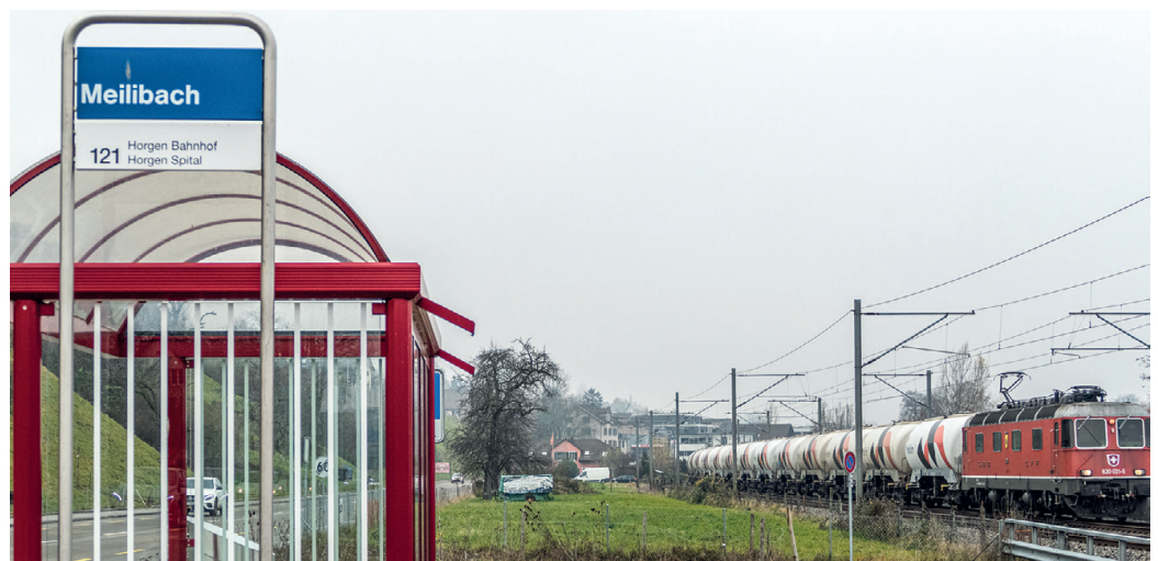
Der künftige Meilibachtunnel soll dereinst im Gebiet Meilibach an der Grenze von Horgen und Wädenswil in die linksufrige Bahnstrecke münden. (Archivbild: Arthur Schächli)
