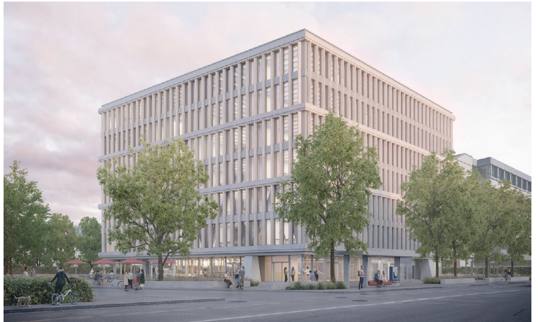
Der Neubau der Berufsschule Winterthur an der Tösstalstrasse soll dafür sorgen, dass pro Tag um die 1100 Lehrlinge unterrichtet werden können. (Visualisierung: Nightnurse Images)
