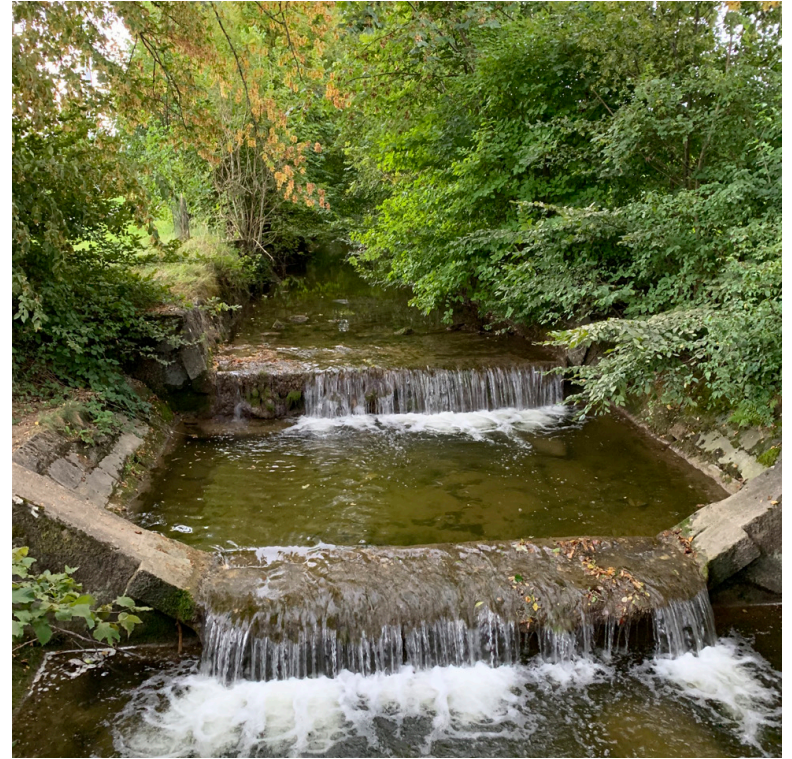
Die künstlichen Schwellen in der Jonen sollen durch fischgängige Rampen ersetzt werden. (Bild: Angela Bernetta)
