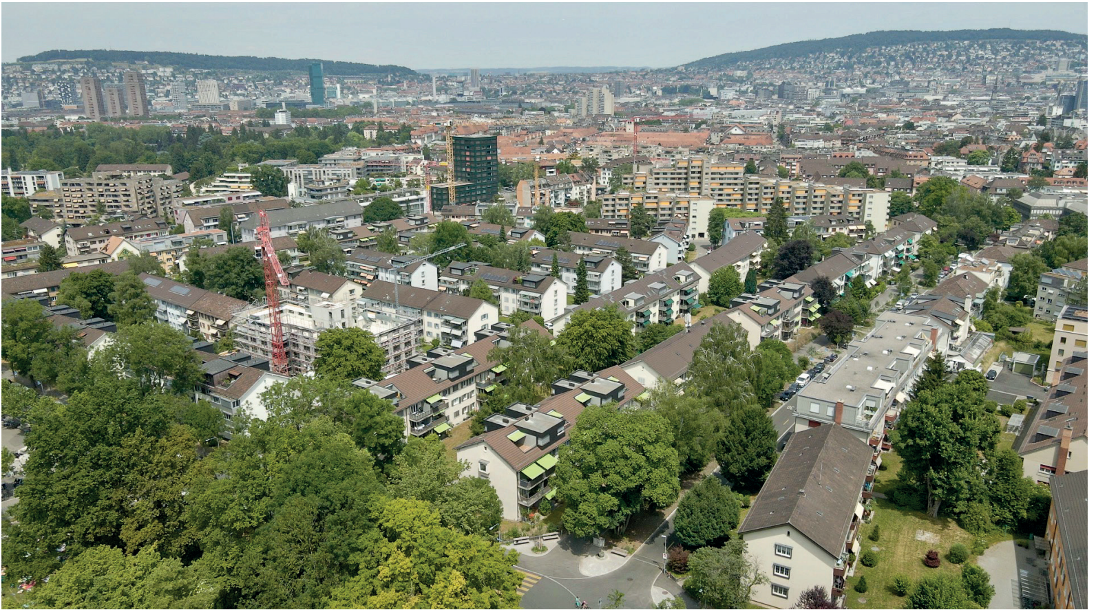
Im Jahre 2005 wurde die Siedlung Heuried-Küngenmatt kernsaniert. (Bild: zVg.)
