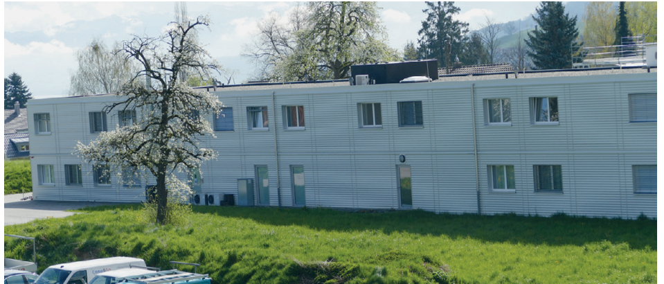
Das Areal mit dem provisorischen Flüchtlings-Pavillon will der Gemeinderat vorderhand nicht für Genossenschaftswohnungen abgeben. (Bild: Arthur Schäppi)
