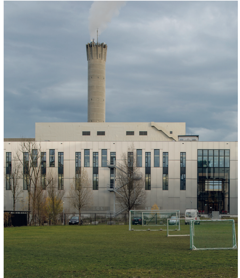
Die dritte Verbrennungslinie im Hagenholz kostet 367 Millionen Franken. Das letzte Wort haben die Stimmberechtigten. (Bild: Thomas Hussel / Baugeschichtliches Archiv)
