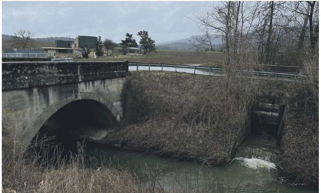
Hier fliesst der Dorfbach Otelfingen in den Furtbach. Im Hintergrund links befindet sich die ARA Otelfingen-Furtbach. (Bild: Sergio Scagliola)
